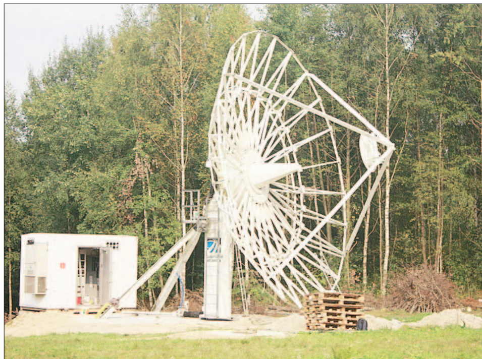
Radioteleskop w czasie budowy
